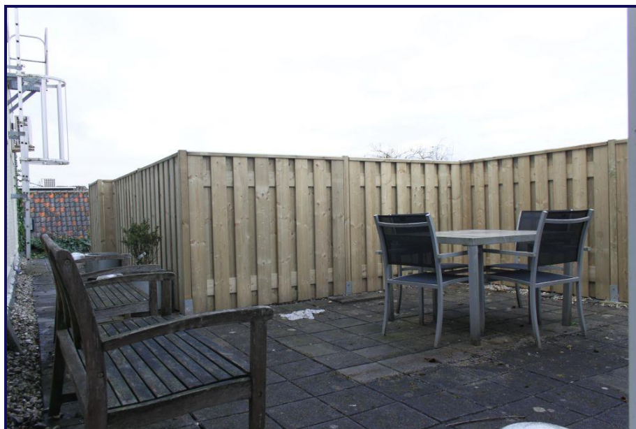
Dakterras eerste verdieping
